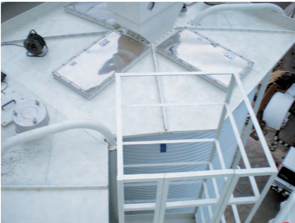
ILUSTRACIÓN 20. Montaje de venteo en cubierta de silos (Por cortesía de Impex Europa, S.L.)
