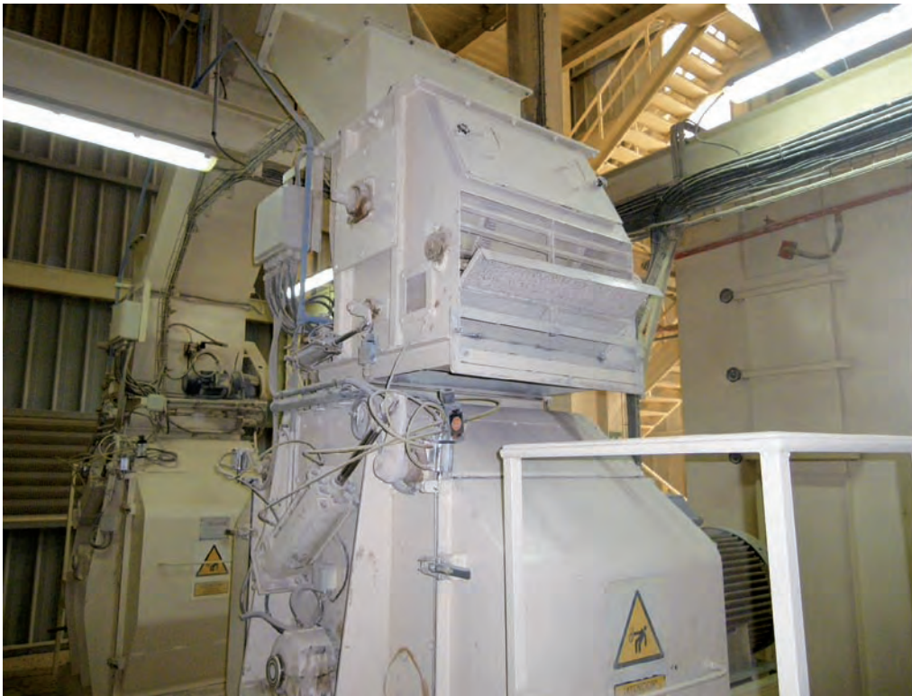
ILUSTRACIÓN 17. Sistema de limpieza de cuerpos extraños en alimentador de molino (Por cortesía de Nanta)
