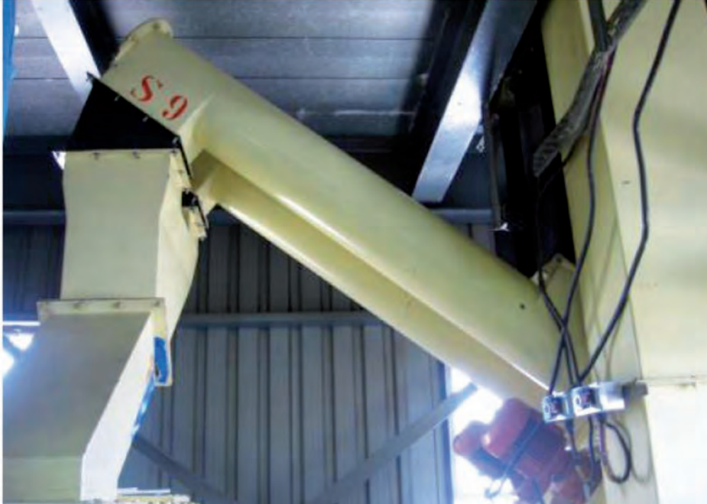
ILUSTRACIÓN 25. Alimentadores de tornillo sinfín pueden actuar como aislamiento de explosión (Por cortesía de SABMiller plc.)
