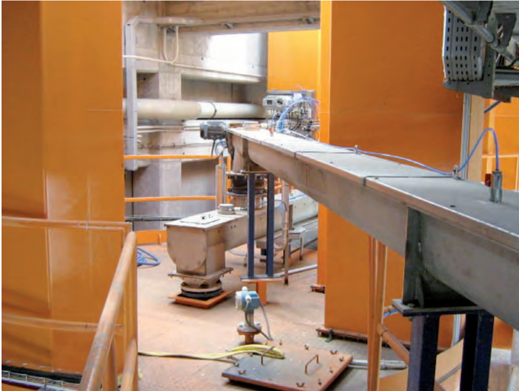
ILUSTRACIÓN 19. Montaje de venteo en silos y conducto al exterior (Por cortesía de Emasa)
