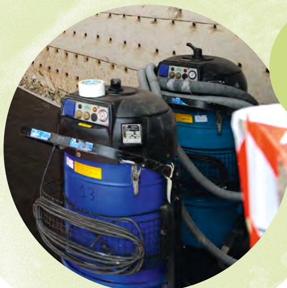
Figure 11. Nettoyage des sols contaminés après déversement à l'aide d'un aspirateur équipé de filtre H.
