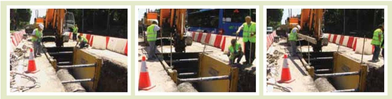
Las protecciones de borde de zanja (vallado de protección de la excavación) sólo serán retiradas por razones de tipo técnico, (retroexcavadora en excavación lateral, introducción de entibación, etc.) debiendo ser repuestas inmediatamente. Además se tomarán las medidas preventivas oportunas que impidan el acceso a dicha zona, mediante cierre o balizamiento de las áreas afectadas y en su defecto mediante el uso de arneses de seguridad.
