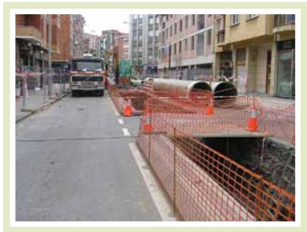
Se recomienda instalar el vallado a una distancia del borde de excavación no menor de 1,50 m.
