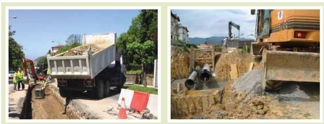
El terreno siempre tiende a restablecer su posición natural por lo que debemos tener en cuenta su consistencia, presiones laterales, estabilidad, estratos, humedad, densidad, permeabilidad, vibraciones, etc.
