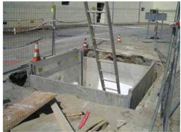
Las estructuras flexibles (deformables), son aquellas que, experimentan deformaciones de flexión. Dentro de estas estructuras se encuentran las entibaciones, definidas como estructuras auxiliares y desmontables destinadas a sostener las excavaciones que ofrecen riesgo de descompresión del terreno y hundimiento, perfectamente aplicable a zanjas, pozos...
