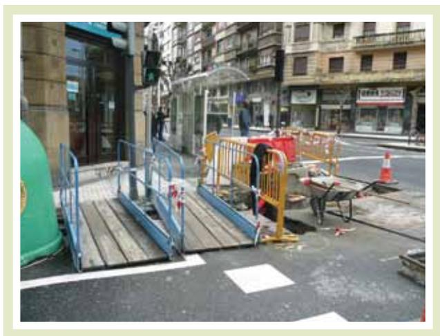
Para tránsito de terceros se dispondrán pasarelas cuando sea necesario para el paso sobre las zanjas. Dichas pasarelas serán de resistencia adecuada, de un ancho mínimo de 150 cm. y dotadas en su contorno de banderillas reglamentarias.
