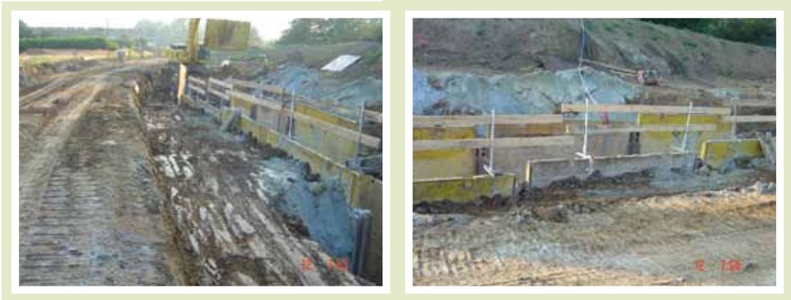
El montaje y desmontaje de la protección se deberá hacer siguiendo las instrucciones del fabricante y lo efectuará personal autorizado, que comprobará antes de su colocación que todas las piezas están en perfecto estado, sustituyendo si es preciso las partes deterioradas.
