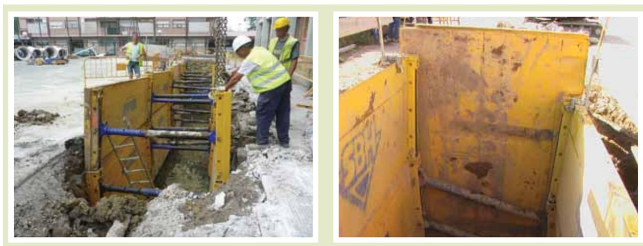
Salvo justificación técnica constatada, está terminantemente prohibida la subexcavación del talud o paramento por debajo de la entibación. Deberá rellenarse el trasdós de la entibación para asegurar un contacto adecuado entre ésta y el terreno.
