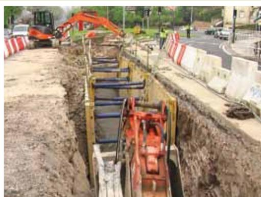
Definimos un sistema de entibación como el conjunto de componentes prefabricados destinados a sostener las paredes verticales de las zanjas.
