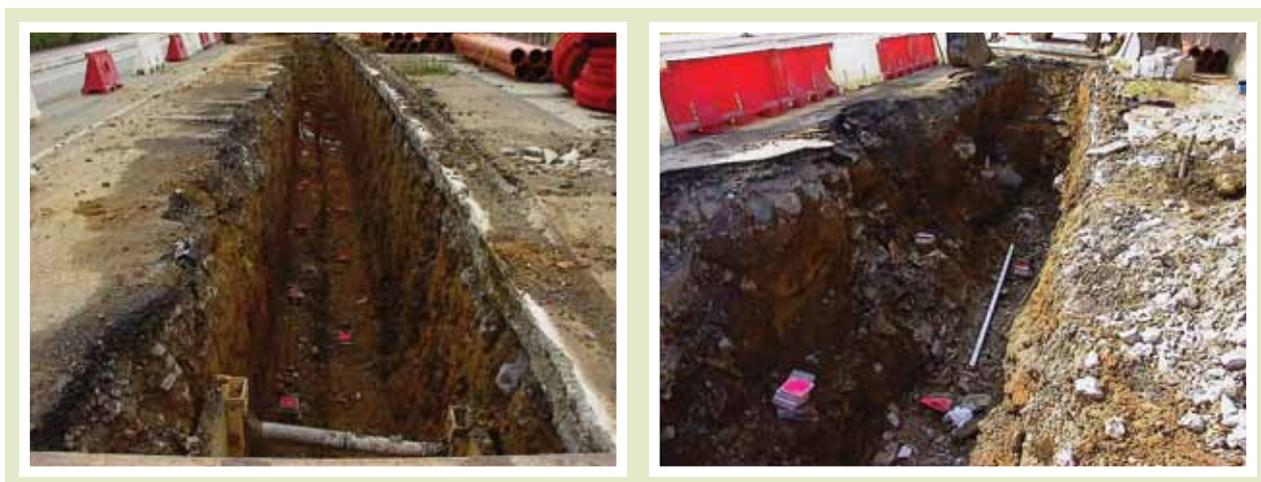
La entibación adquiere una especial importancia, que debe ser obligatoria a partir de una determinada profundidad, en cada caso. La anchura de la zanja ha de ser tal que permita la ejecución de los trabajos en presencia de entibaciones suficientes en número y dimensiones.
