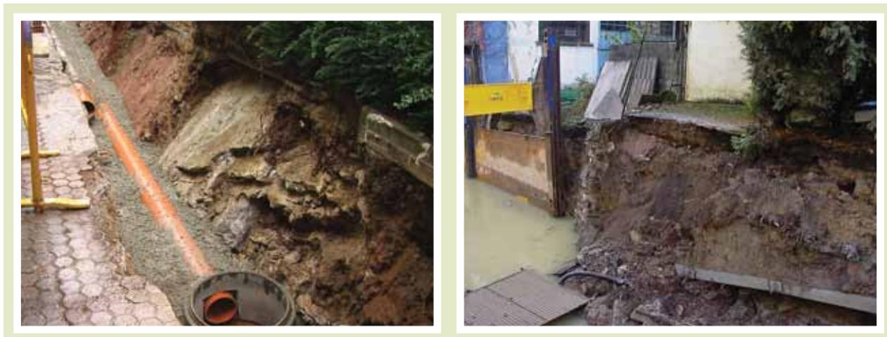
En los trabajos en zanja un importante riesgo de desplome está generado por la limitación de la anchura, puesto que una pequeña cantidad de material desprendido puede rellenar toda la sección con el consiguiente sepultamiento de los trabajadores.
