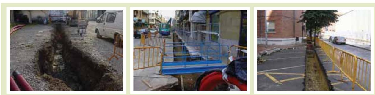
El frente de avance y taludes laterales serán revisados diariamente por el Capataz, Encargado o Recurso Preventivo, antes de reanudar las tareas interrumpidas por cualquier causa, con el fin de detectar las alteraciones del terreno que denoten riesgo de desprendimiento, así como que deberá revisar las entibaciones realizadas, tensando los codales que se hayan aflojado.
