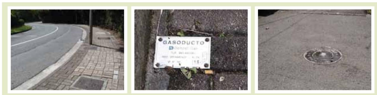
Una vez localizada la conducción, se procederá a señalizarla, marcando dirección y profundidad.
