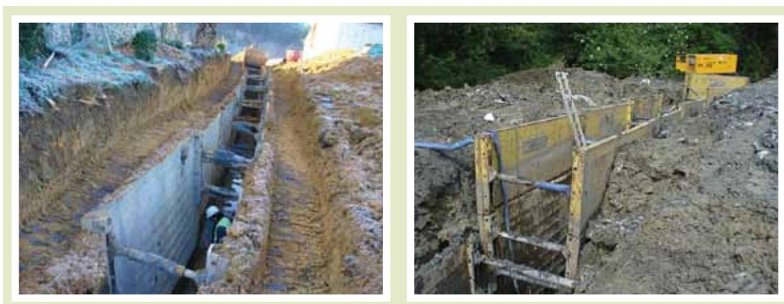
Los trabajos de relleno y compactación del terreno se realizarán, con carácter general, con anterioridad o, cuando menos, simultáneamente a la extracción de la entibación.
