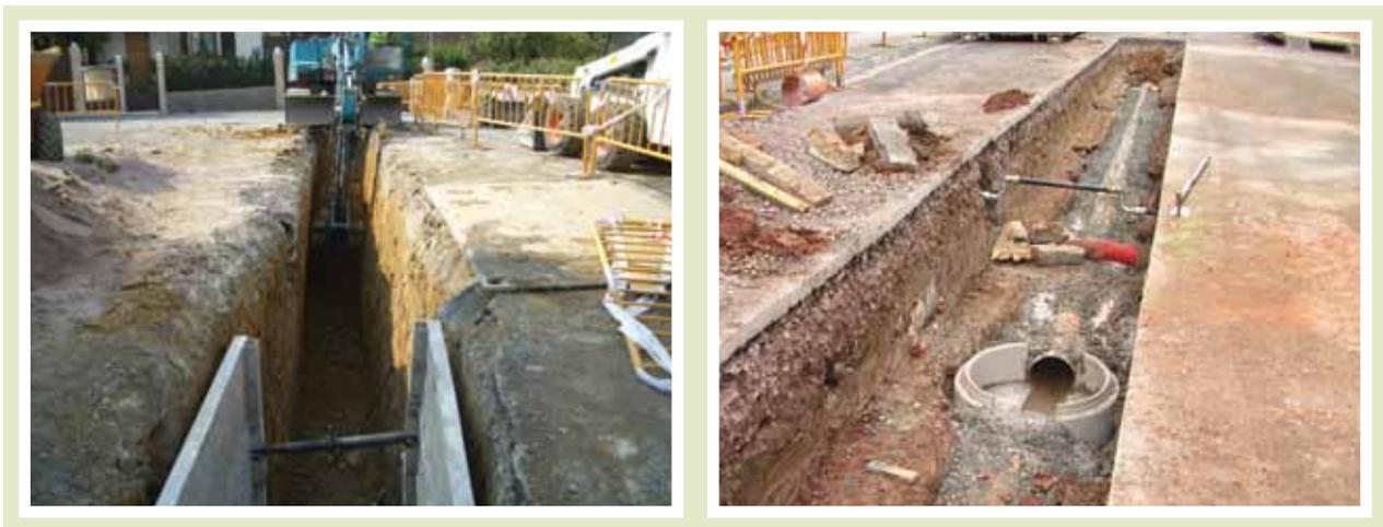
Ante la imposibilidad de dar a las paredes la pendiente del talud natural, por falta de espacio en la mayoría de las ocasiones, se deberá proceder a su entibación, es decir, a la implantación de un sistema de contención que evite su desplome. Por lo tanto, la zanja puede presentar paredes aseguradas con diferentes sistemas de entibación, que en cada caso, deben estar certificados.
