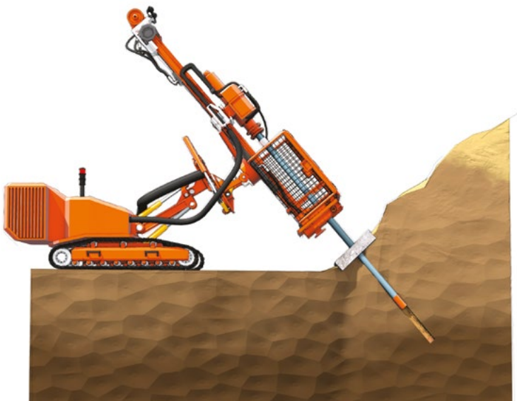
■ Figure 2. Clous pour stabilisation
