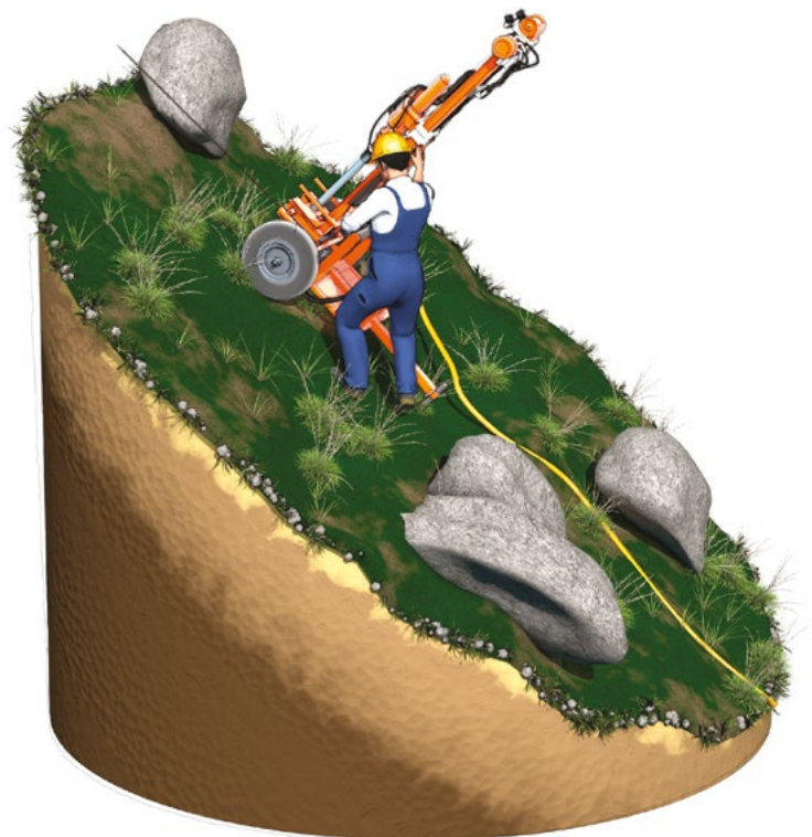
■ Figure 14. Travaux d'accès difficile
