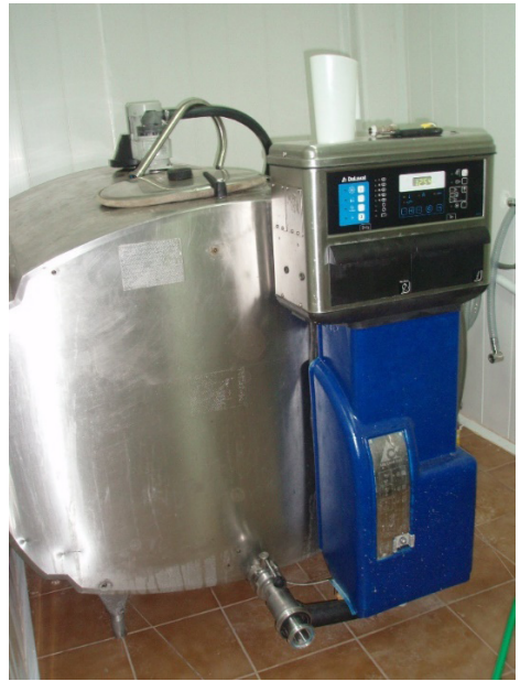
Foto 5 Sistemas de limpieza del circuito de leche
