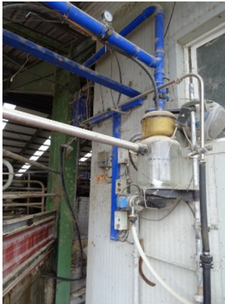
Foto 5 Sistemas de limpieza del circuito de leche
