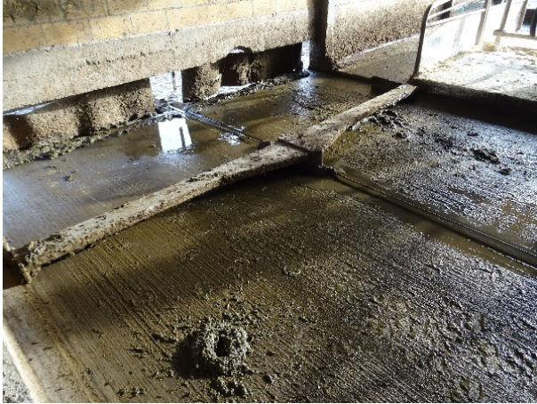
Foto 7 Limpeza mecánica de pasillos
