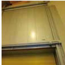
◀ Puerta de cierre automático que asegura la compartimentación en caso de incendio o alta concentración de alcohol en la atmósfera.
