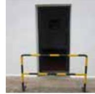
▲ Valla de protección en la salida de la cabina de control de la báscula
