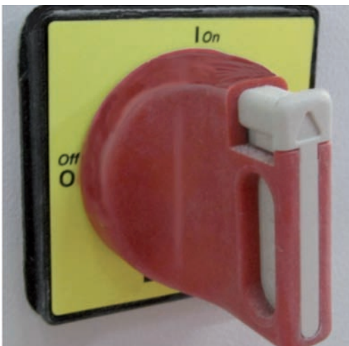
Foto 39: seccionador activo, está en 1. Dispone de posibilidad de bloqueo mediante candado o similar para cuando es necesario.
