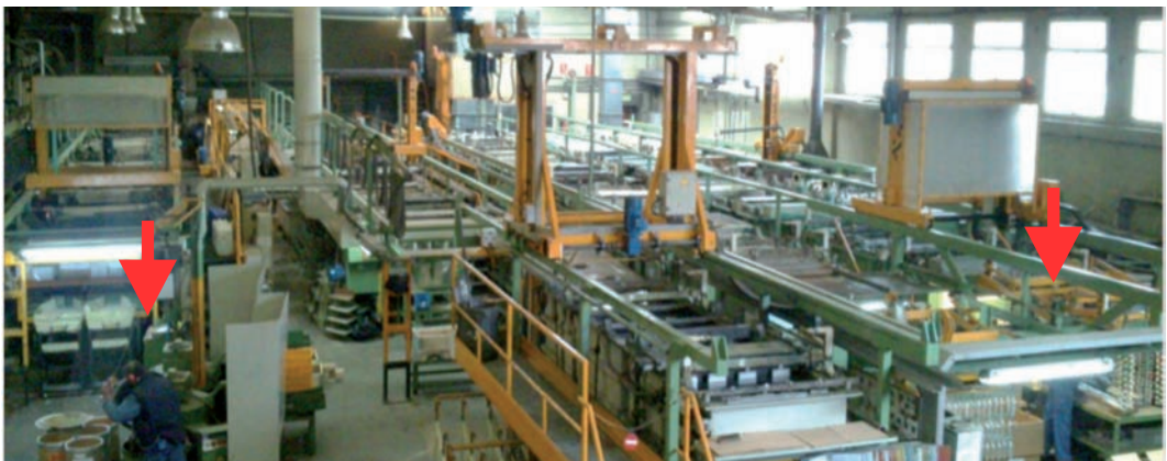
Foto 4: en esta planta los puestos que controlan los equipos no tienen una visión completa de las diferentes partes ni de ellos entre sí. Les son necesarios medios adicionales como procedimientos de trabajo, cámaras, mandos simultáneos, controles de acceso, etc.
