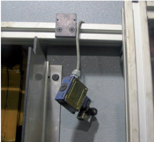
Foto 22: dispositivo de seguridad eliminado.
