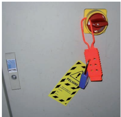
Foto 40: seccionador bloqueado para consignar la máquina.
