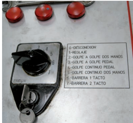
Foto 6: selector de mando donde se ven las opciones de barrera a 1 tacto y a 2 tectos, que implican usar la barrera fotoeléctrica o inmaterial no como protección para el trabajador sino como accionamiento de la máquina. Estos modos aunque están contemplados en la normativa, se recomienda que no se usen. Si es necesario, los operadores tendrán formación específica para usarlos y se les dotará de medidas de seguridad adicionales.
