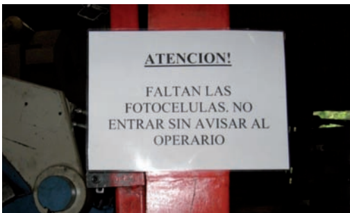
Foto 36: sustituir los sistemas de protección por un cartel no es una opción recomendable.
