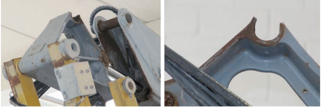
Fotos 11 A y B: plataforma elevadora rota en servicio por un mantenimiento insuficiente. Las partes que necesitan un mantenimiento tienen que venir especificadas en el manual de instrucciones.
