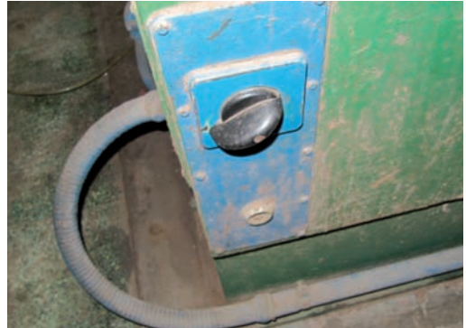
Foto 41: seccionador inadecuado, carece de la posibilidad de ser bloqueado para la consignación de la máquina.
