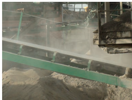
Fig. Cinta sin capotaje, ni humectación del material, y acumulación de polvo por falta de plan de limpieza.
