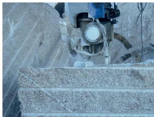
Fig. Captación localizada en la perforadora
