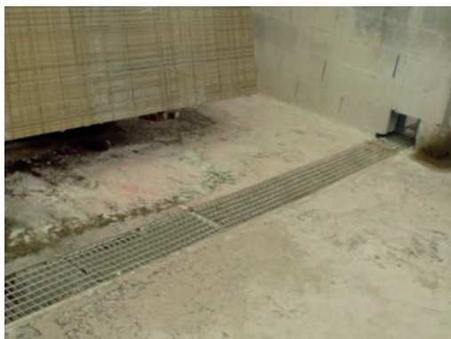
Fig. En las naves es fundamental la gestión del residuo húmedo generado, parte de la cual pasa por contar con una canalización funcionando adecuadamente.
