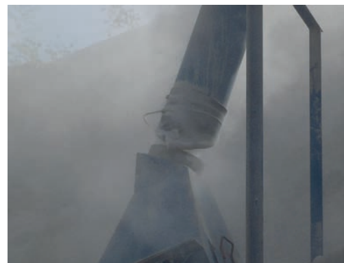
Fig. Fallo de mantenimiento en punto de trasvase. Se insiste en la Guía en la importancia de contar con un plan de mantenimiento específico para medidas de prevención.
