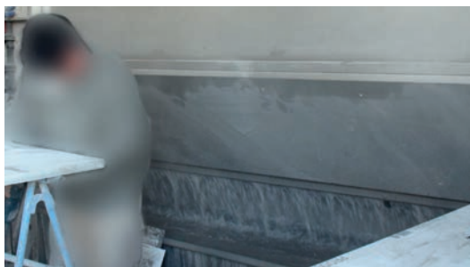
Fig. La ubicación del trabajador respecto al elemento de captación es determinante en su eficacia. Aquí tiene máxima importancia tanto un diseño riguroso de la solución, como una formación adecuada del trabajador. En la imagen de la izquierda la posición dificulta el arrastre de partículas. En la de la derecha, el trabajador se posiciona demasiado lejos de la aspiración.
