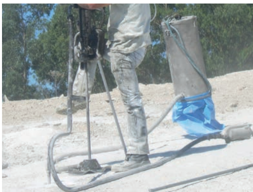
Fig. Perforación manual con captación
