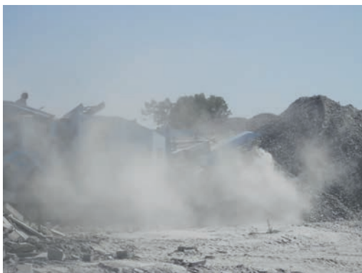
Fig. Elevada concentración de polvo en la planta por deficiencias en la prevención.
