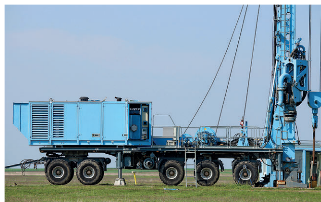
Figura 4. Equipo de perforación móvil.
