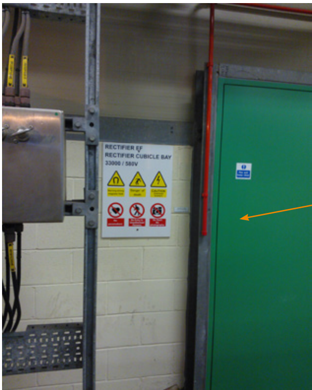
Figura 3.3. Restricción de acceso al módulo de cubículos de rectificadores
