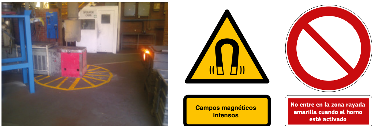
Figura 8.7. Marcas pintadas en el suelo y señal de advertencia asociada para indicar el área en la que se pueden superar los niveles de actuación
