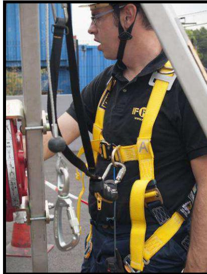
Operario conectado al trípode mediante un cabo con absorbedor
