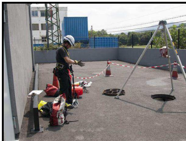
Pese a que el fabricante certifique la resistencia de estos anclajes, al instalarse sobre otros elementos, se deberá verificar la viabilidad de la instalación. Para ello el conjunto deberá soportar al menos una tensión de 10kN.
